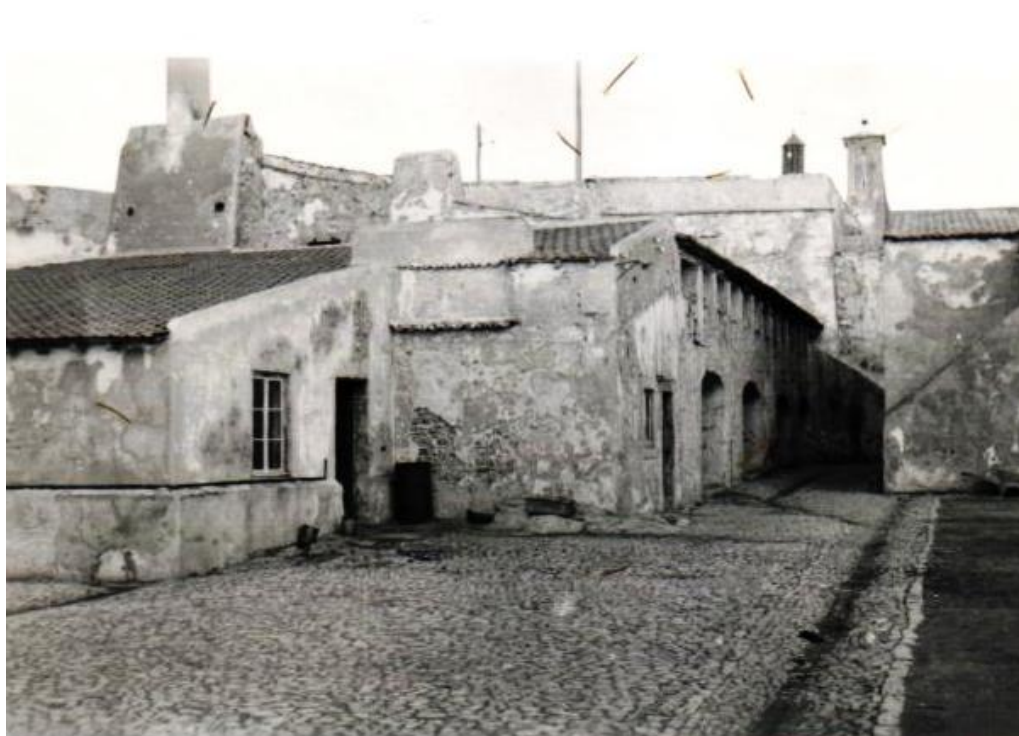
Aspeto das instalações da prisão de Peniche, anos 30 do séc. XX. Direção Geral dos Serviços de Reinserção e Serviços Prisionais
