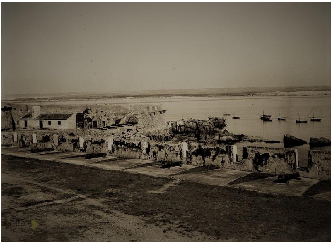
As velhas e decrépitas instalações da cadeia de Peniche antes das obras de 1953, SIPA
