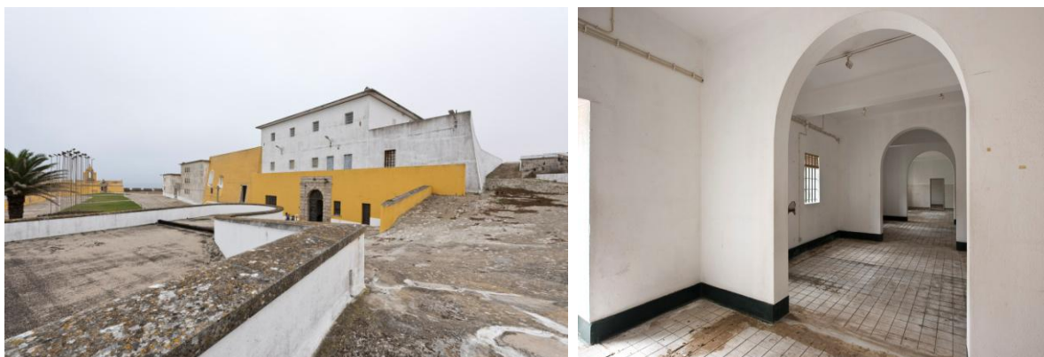
O Pavilhão C é o edifício mais alto, pintado de branco. Na foto ao lado as salas do 1º piso do Pavilhão C mas já todas ligadas entre si, quando antes eram camaratas e espaços separados. Foto DGPC
