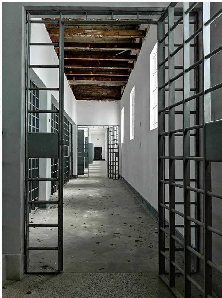
Corredor do 3º piso do Pavilhão C. Foto MNRL
